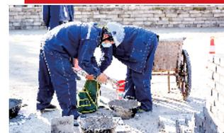
瓦工选手进行放线、挂线、砌砖、划缝、留搓等各道工序
