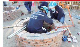
水工选手完成管道连接和阀门、水表、水嘴的安装
