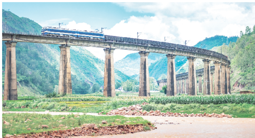
列车驶过成昆铁路大田菁跨龙川江大桥
