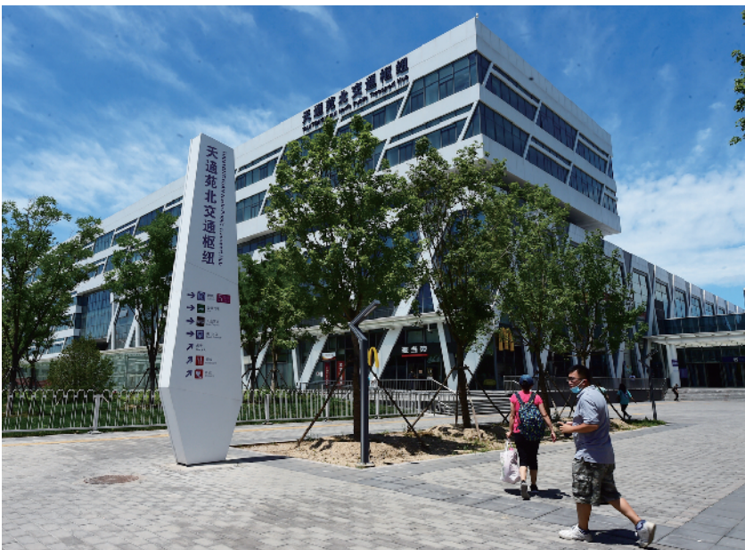
新建的天通苑北交通枢纽已经投入使用
