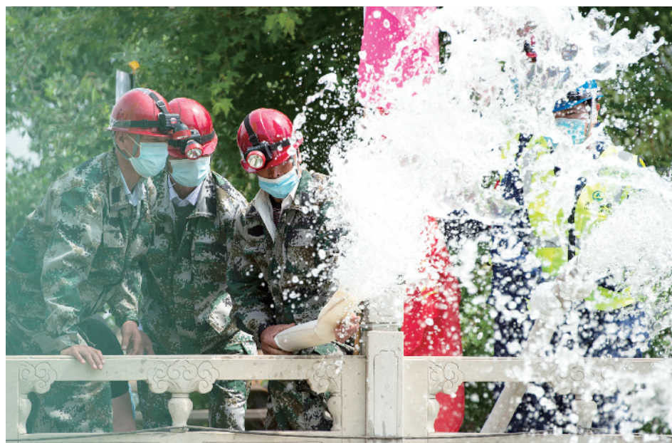
排水项目上,多台抽水泵同时作业,场面壮观
