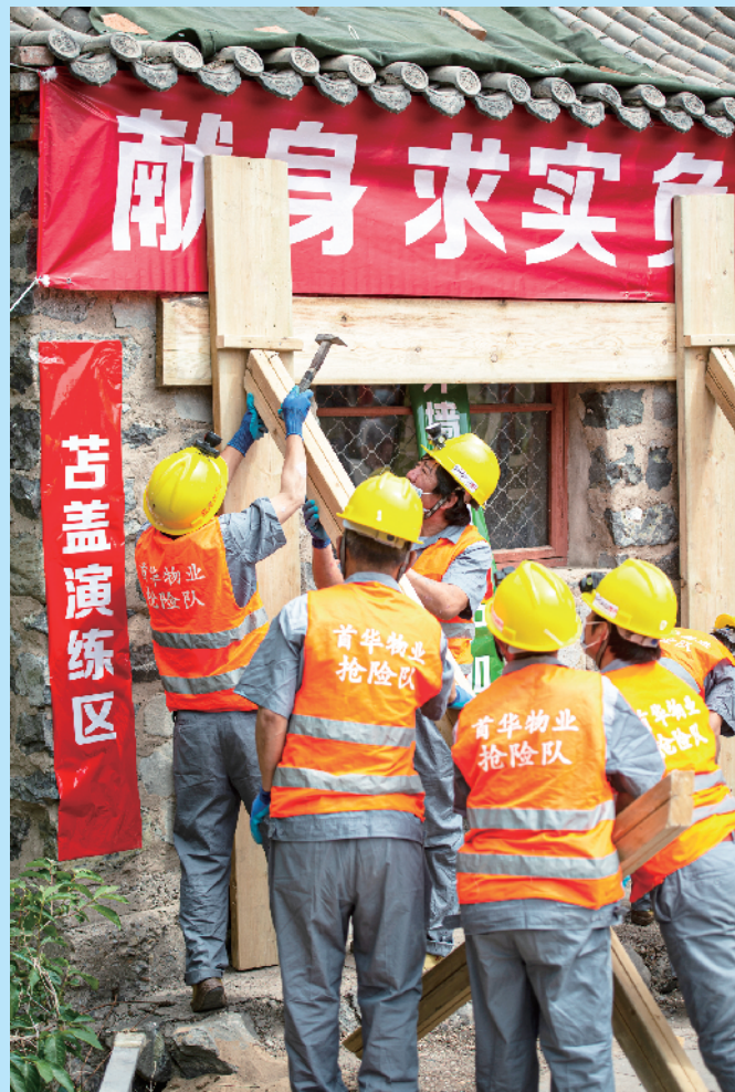
苫盖演练区,演习人员合力为房屋墙体加固
