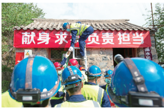
队员们互相配合对屋顶进行加固
