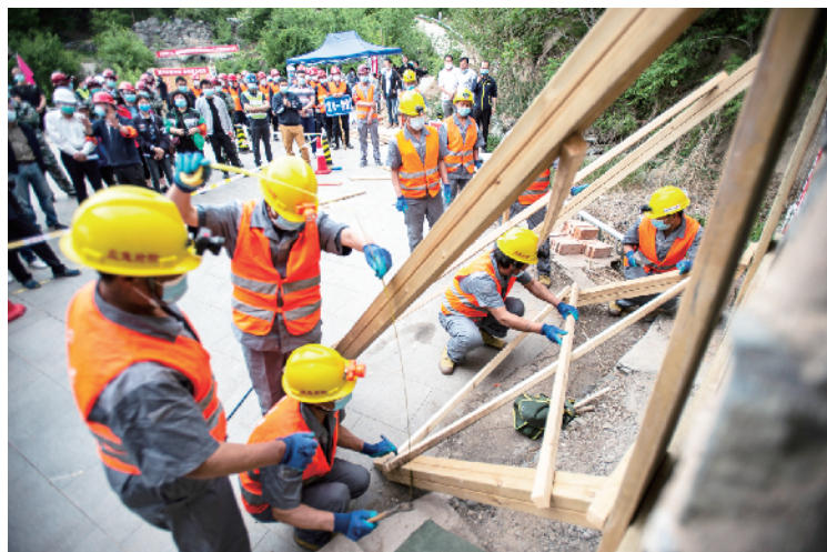
队员们通过对材料切割、测量,在极短的时间内完成房屋外侧的加固工作
