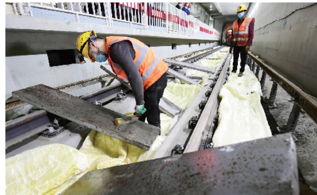
工人对钢模进行涂油处理
