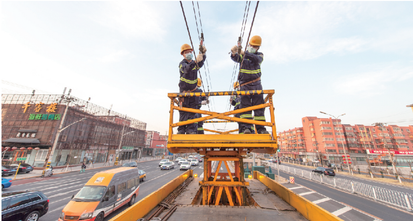
电车线网设备抢修要在600伏高压线旁完成
