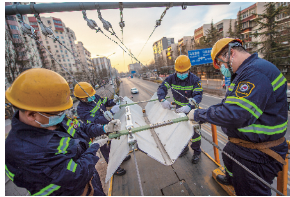
在大约7平方米的作业平台上，四个人紧盯眼前的吊点，观察螺丝有没有松动的迹象
