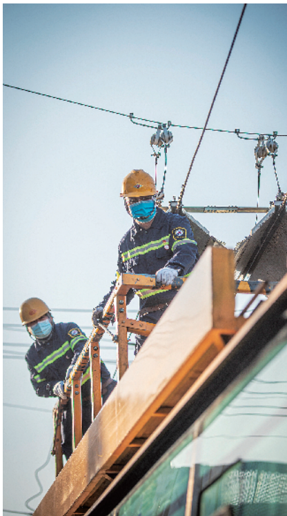
爬上作业平台后，队员随时和司机师傅沟通调整平台高度
