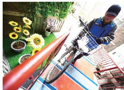
将单元门前原来高台阶的步梯加长,减缓坡度,用木板垫出自行车道,方便了居民。
