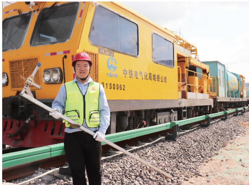
将道尺垂直于钢轨上方，结合施工图纸将定位点数值在道尺上调整并固定，将校正水平仪上四块钢化玻璃取下，可准确的将定位点位置标注出来，取代了传统的定位磨具，同时更加有效确保定位点位置垂直于钢轨，根据预期，能将定位点垂直轨道合格率从85%提高至100%，大大减少了后期修改所占用的时间及人力资源。而且道尺在灌注及调整化学锚栓时，可利用测量尺直接测量孔深或化学锚栓的外露是否符合设计要求，并使用校正水平仪直接检查四颗化学锚栓之间的横向、纵向间距是否符合要求，还可调整并保证锚栓上表面水平，提升了施工工艺水平。
