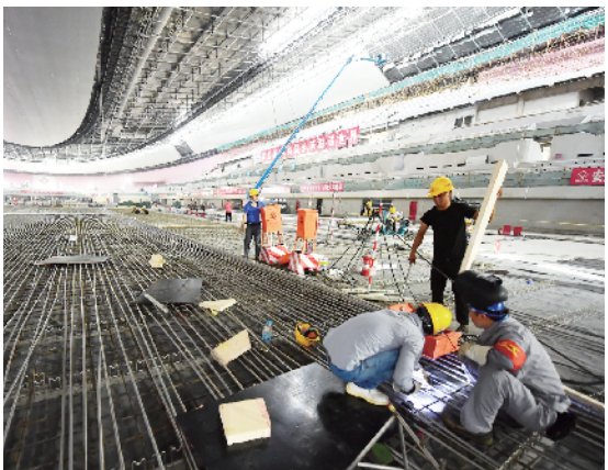
施工人员在铺设、焊接制冷钢管。
