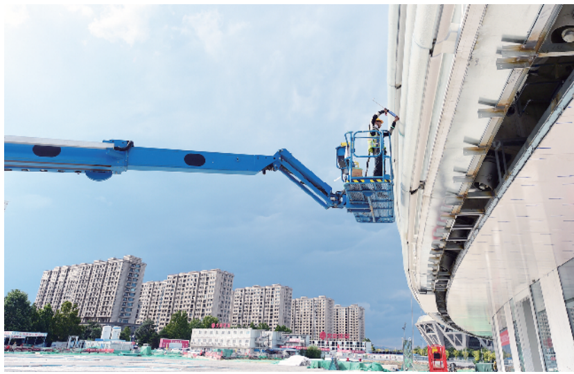
工人在馆外自驾升降车，对玻璃墙注胶严缝。
