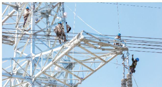
正在挥汗工作的电力工人
