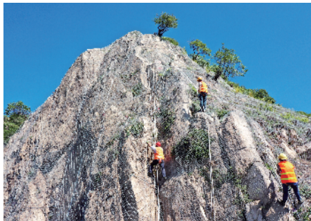
施工人员在山腰间铺设钢网。
