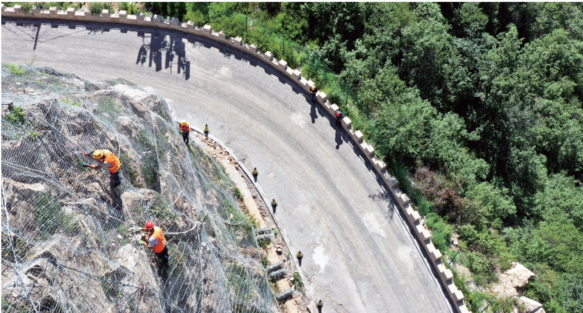
▲位于延庆松山的松闫路是冬奥交通保障项目，路旁多陡坡，需要“蜘蛛人”定期进行清理排查。
