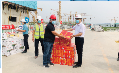
大兴区委副书记霍光峰(右)带队到北京大兴国际机场噪声区安置房施工现场送清凉
