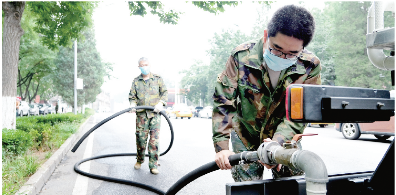
停车、接管、浇水，快速操作，快速离场，以保道路畅通。
