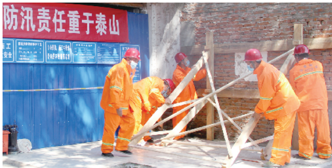
德源集团进行墙体支撑演习
