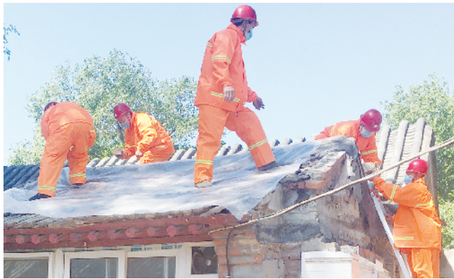
德源集团抢险人员苫盖房屋
