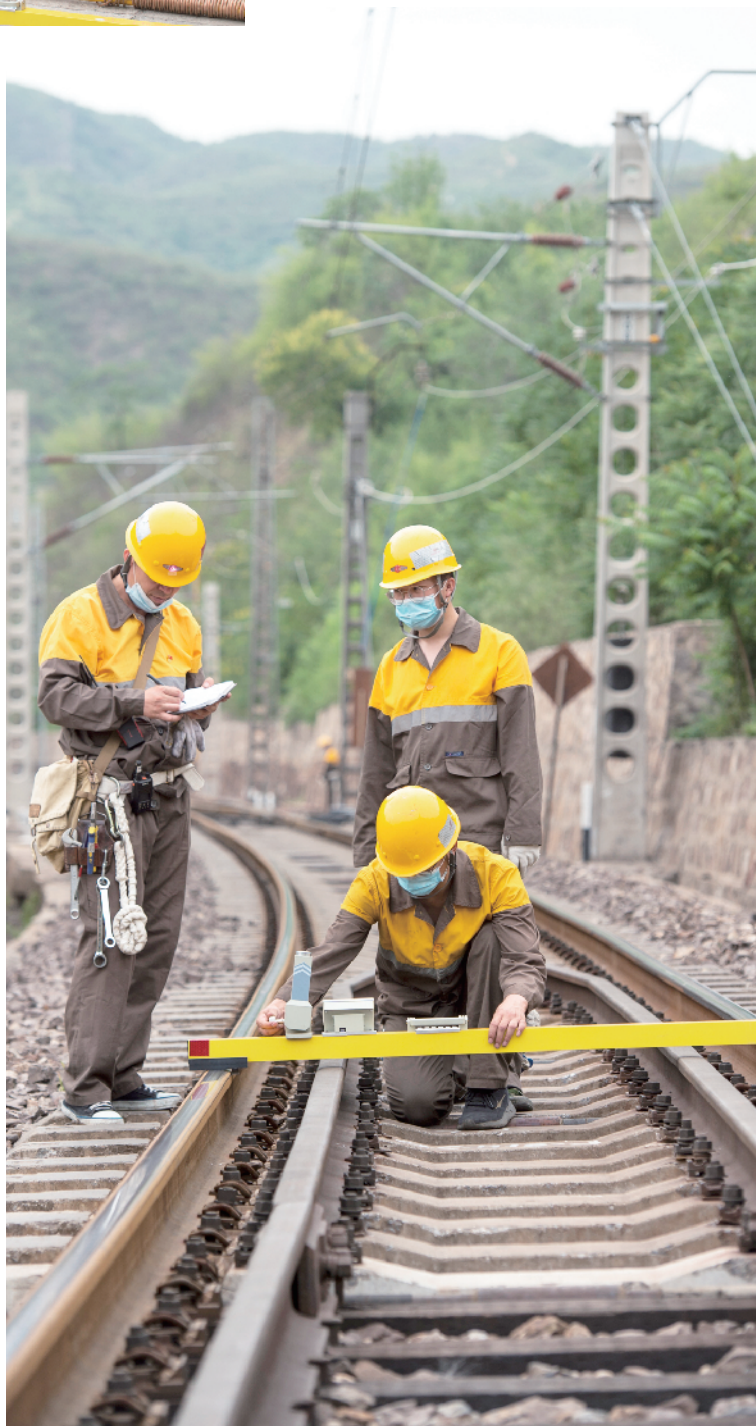
工人使用激光尺测量接触网参数,保证列车通过电压供给平稳。
