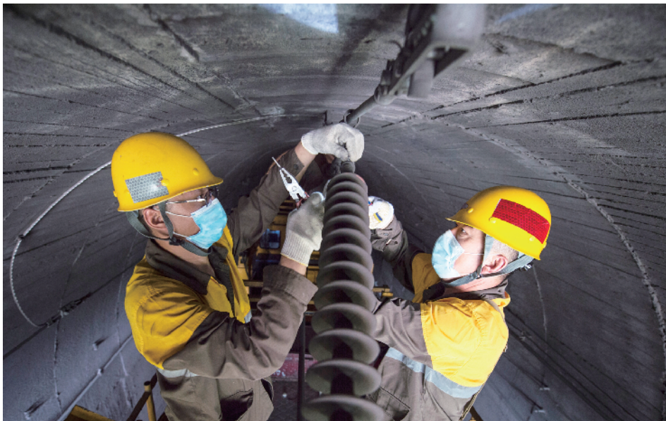
丰沙线上,工人们使用力矩扳手等专业工具检查紧固接触线侧吊弦线夹。
