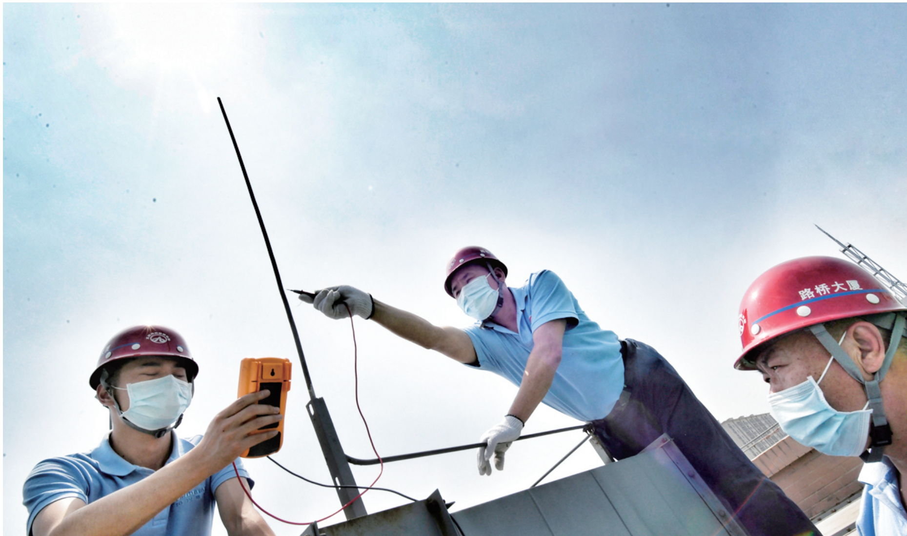
北京市政路桥恒兴物业管理集团的职工对辖区内楼宇的避雷设施进行检修。
