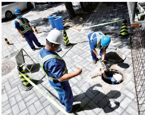
自来水集团维修人员对供水管线设施进行检修。 本报记者 于佳 摄
