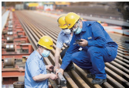
工人们正在对钢轨进行焊前检查。
