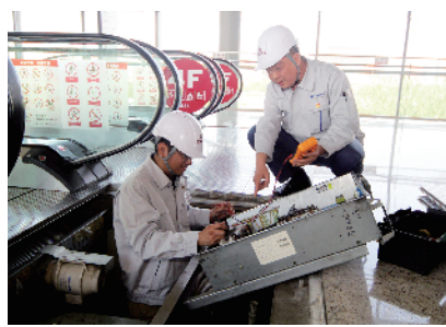
2014年北京APEC会议召开前夕，陶建伟与同事对自动扶梯安全系统参数进行最终检测校验工作。
