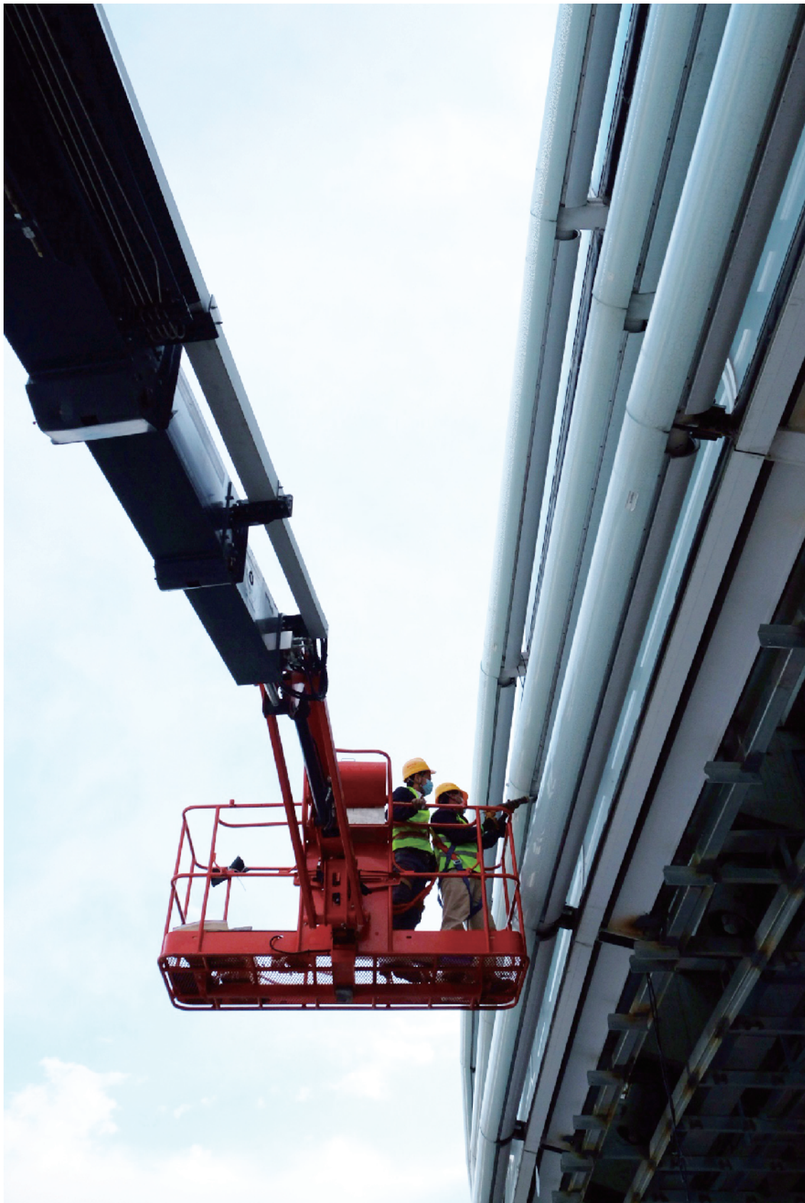
工人正在给玻璃幕墙打胶。
