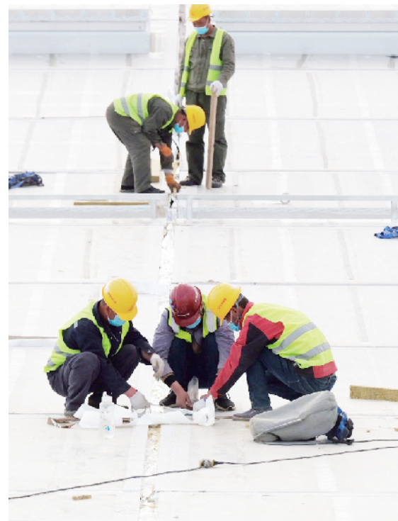
工人在屋面铺设防水材料。
