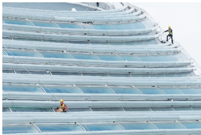
尺寸各不相同的3360块玻璃拼出“冰丝带”曲面幕墙。
