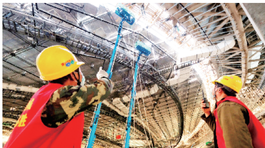
曲臂车上施工人员进行机电风管、虹吸雨水管、桥架及消防管道安装。
