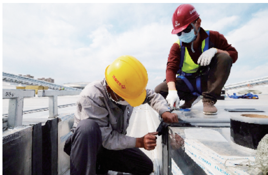
防水生产经理指导工人严格施工。
