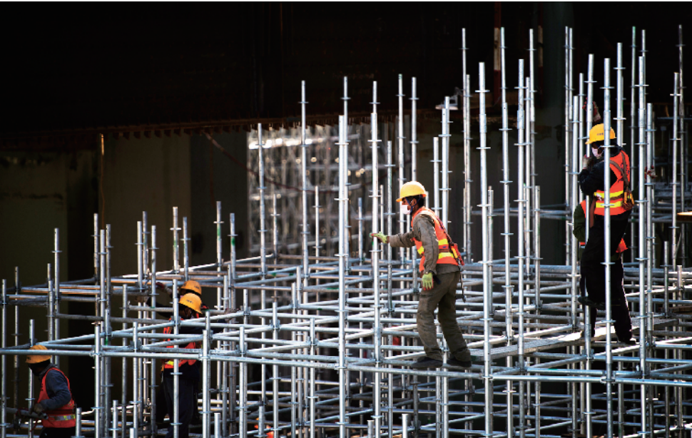
为防控疫情，丰台站工地上不再采用“流水式”的穿插施工法，而是改为平面分散施工。
