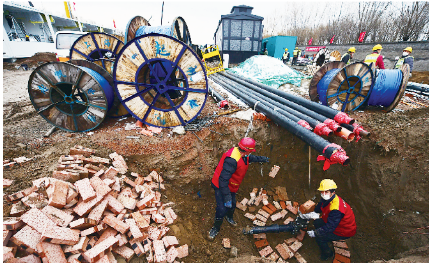
天气恶劣，工程未停。北京建工集团有限公司职工，戴着防护口罩，工作在泥泞的建设工地上。
