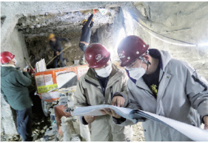
市政路桥技术人员在施工点检视、防控。
