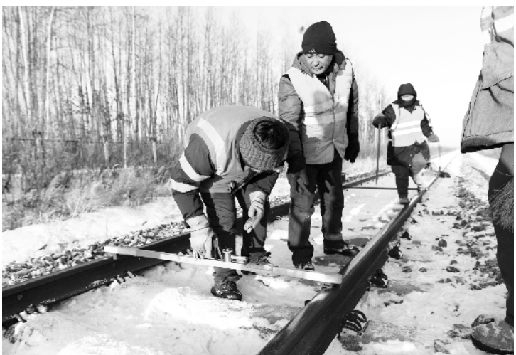
抚远线路工区巡线员对路轨进行养护作业（12月19日摄）。
