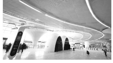
环球度假区站是全市第-拥有大跨拱形钢结构种植屋面的 交通建筑, 也是第一座地景式地 铁车站,钢结构屋顶分种植区及 采光区. 种植区约1万平方米,屋 顶草坪与环球主题公园内的绿化
