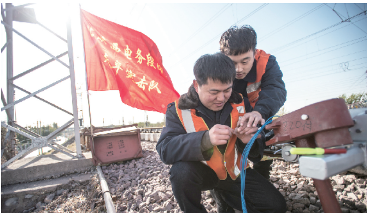
室外温度低至零下，马腾骏、王延庆正在调试设备。
