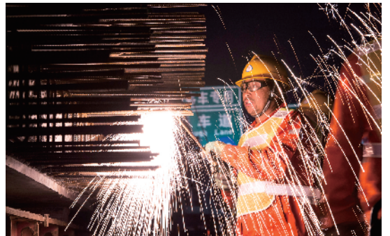
焊工将整块板梁外侧钢筋尺寸进行切割调整。
