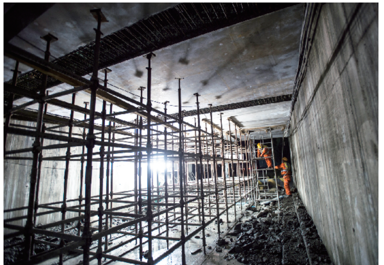
桥体吊装完毕后,桥下紧张的安装作业又开始了。
