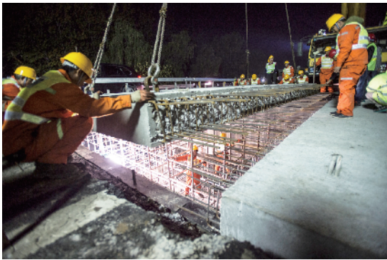
午夜1点,工人们指挥吊车将整块桥放在指定位置。
