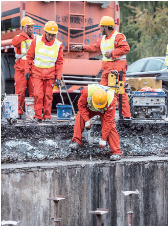
工人们在桥连接处打孔,为安装整块板梁做准备。
