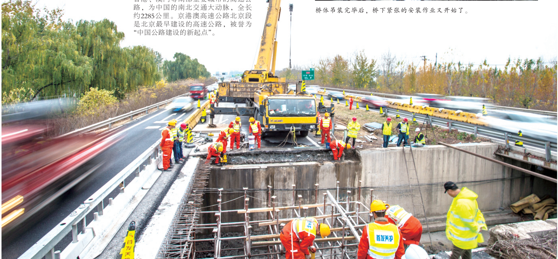
在京港澳高速双向不中断交通的情况下,要在48小时便完成全部施工任务。
