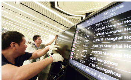
工人正在安装调试站内班机提示大屏。
