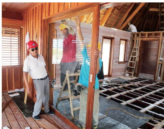
刘光伟 (左)在赤道 几内亚施工 现场
