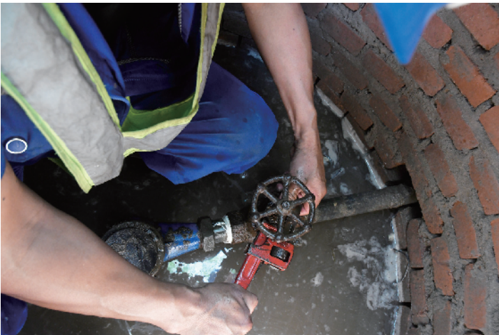
漏水的截门被拧紧，故障得以排除。
