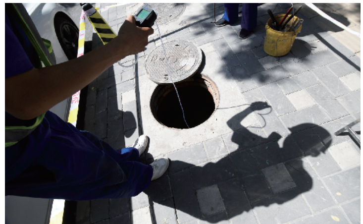
每次下井前，自来水集团职工都要对井下有害气体进行检测。
