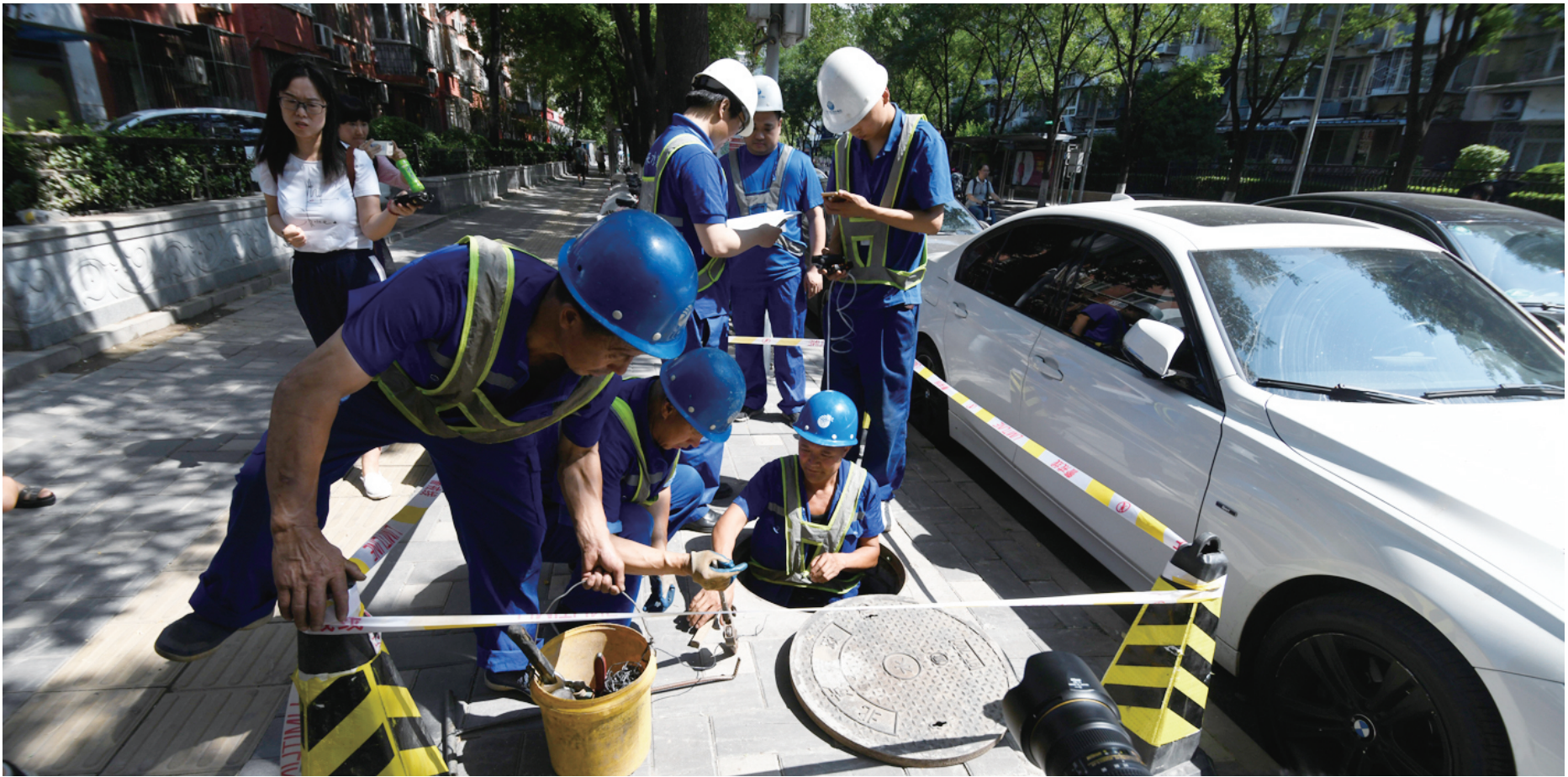
在长椿街南里，自来水集团职工对故障管道进行抢修。
