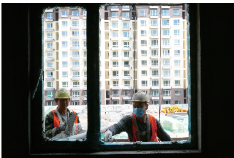
工人精心施工,一期工程全部开始装修,部分楼房已经入住。
