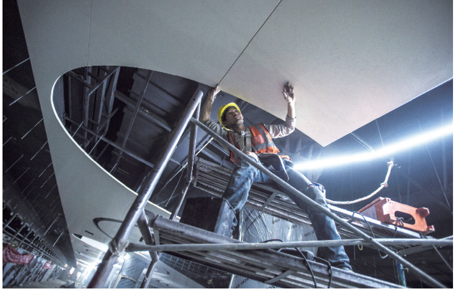
在地铁站内顶部，工人正在安装烟雾探测器。
