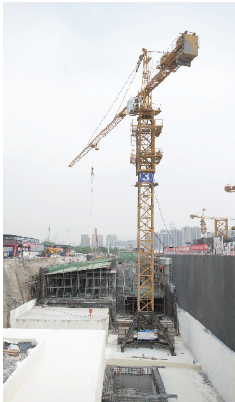
新机场线草桥站主体结构基本成形。
