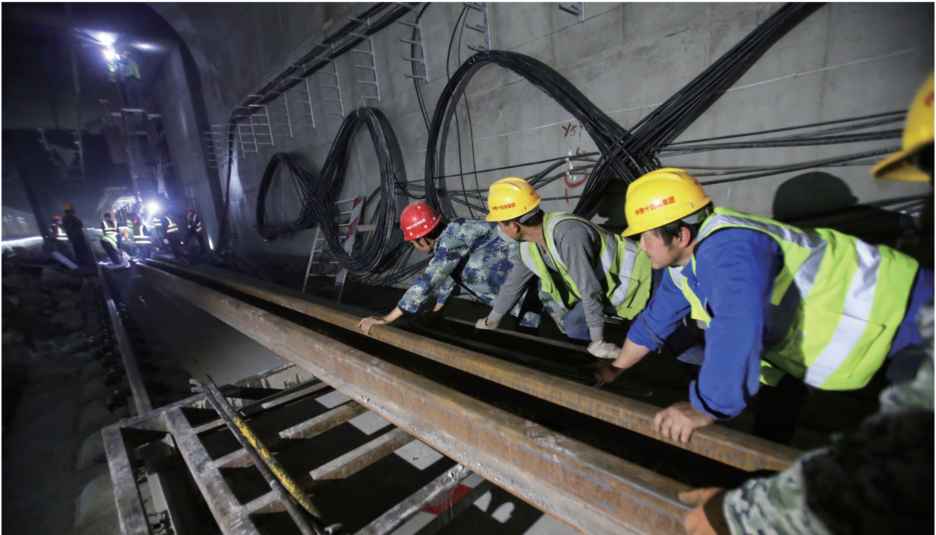
新机场线草桥站隧道内，工人正在铺轨施工作业。
