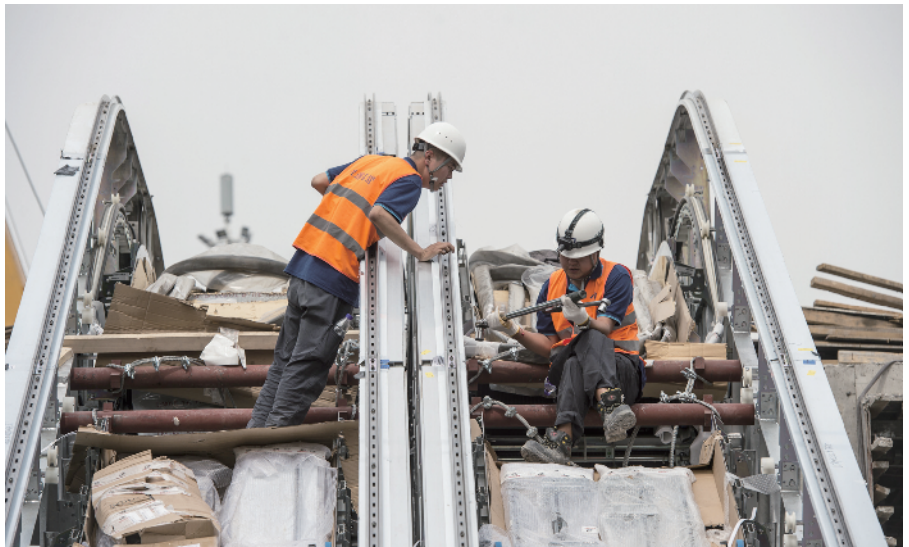
地铁进出站的自动扶梯已经搭建完成。
