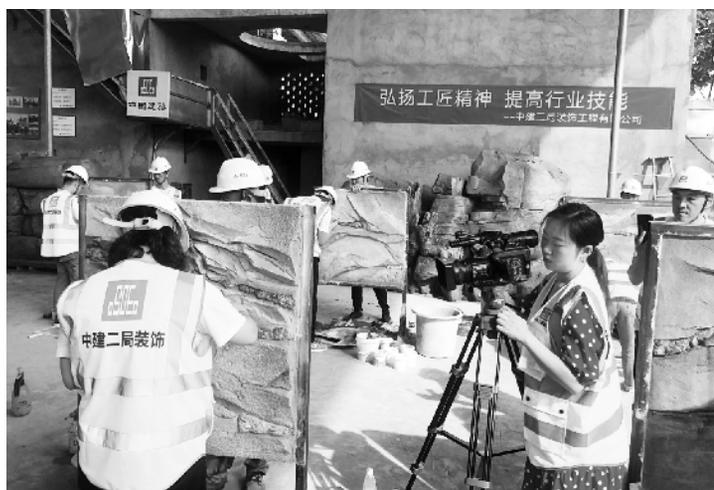
间。为了实现这些建筑创意,在水泥砂浆初凝期的最佳雕刻时期,雕刻师通过多种工艺手法技巧雕刻出纹理和细微造型,上色师通过娴熟的手法、自身色彩搭配的丰富经验和艺术灵感,运用各种高强度耐久性的材质,采用不同纹理及表面油漆喷涂技术来实现各种故事主题的建筑特色,并结
