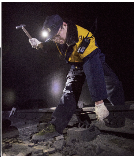
万超使用工具更换不良的轨道接续线，保证通车安全。
