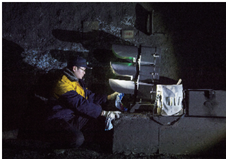
由于隧道内粉尘较多，所以需要定期对信号灯经常擦拭，保证司机能够识别。
