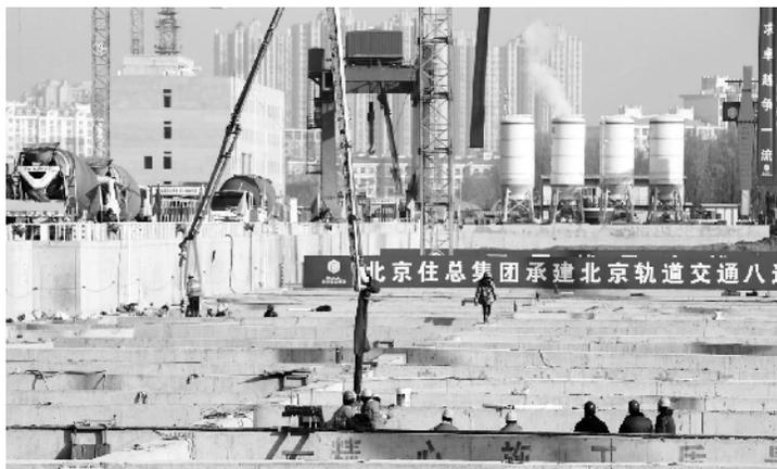
“作为2017年规划新增的地铁车站,位于东六环西侧张家湾地块内的施园站为地下两层双岛式车站,属于超大型车站,规模是普通车站的2.5倍。”施工方北京住总集团八通线南延工程项目负责人王文兵介绍,未来施园站将成为一座重要的三线换乘站,乘客可在施园站完成7号线东延、
