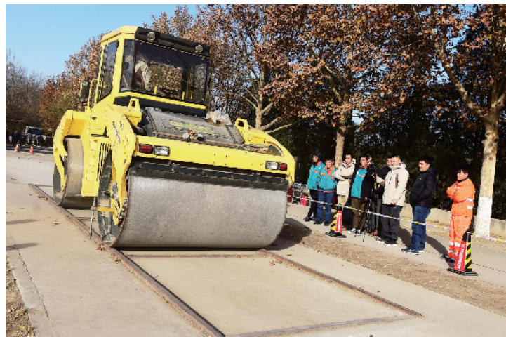
▲选手操作压路机过双边桥，智能传感器对压路机扫描器计分。
