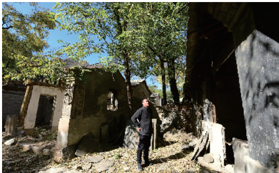
张进刚在改造房屋工地上查看进度。
