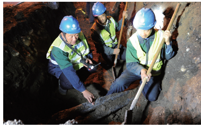
距离居民区较近，无法使用大型的机械设备，只能通过人工肩扛手抬的方式进行施工。
