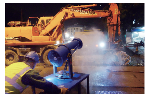
挖掘机作业时，高压水炮机也同步开启，对着挖掘的土方喷射水雾。
