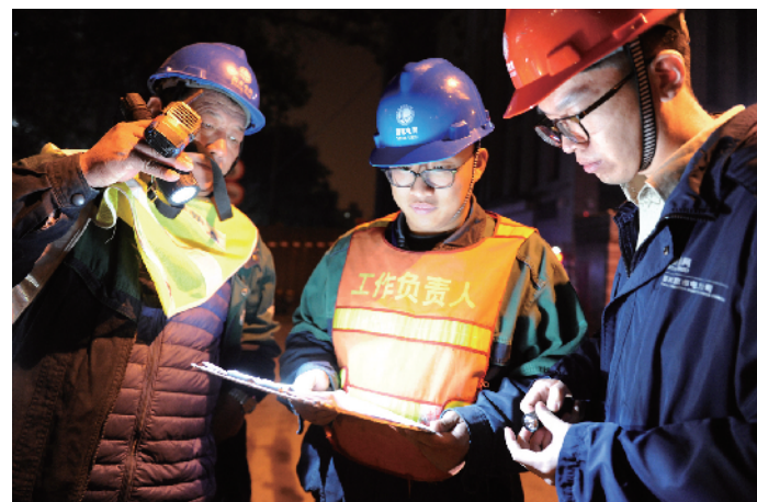
遇到突发情况，工地负责人现场与作业人员商议施工方法。
