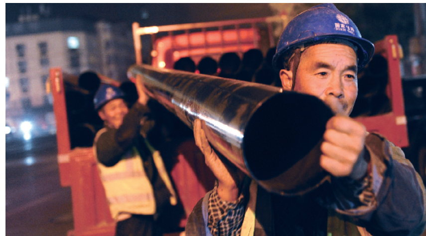
距离居民区较近，无法使用大型的机械设备，只能通过人工肩扛手抬的方式进行施工。
