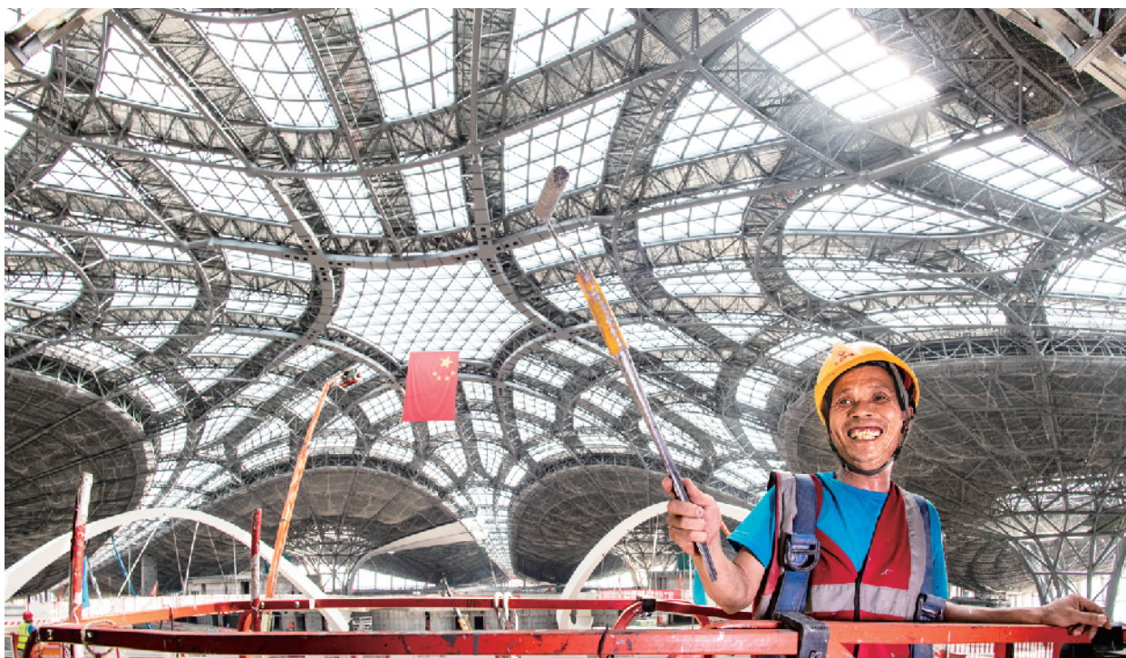
冯胜利 装修工 北京城建集团新机场候机楼项目
