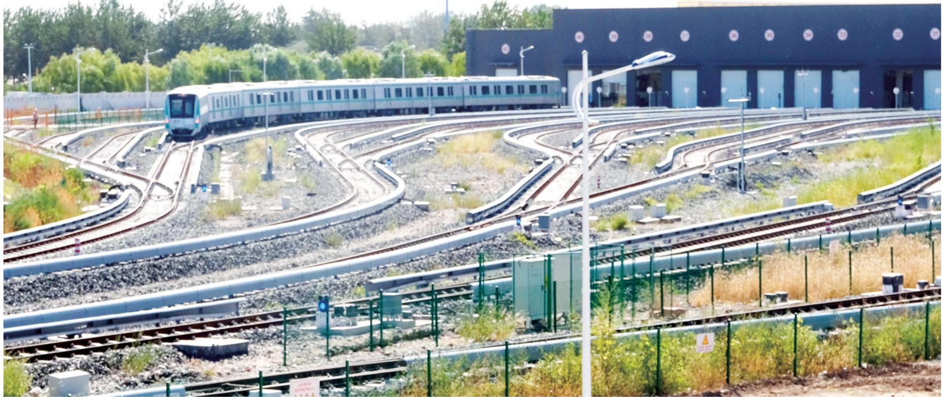
大兴瀛海车辆段车库可以同时停靠58辆车，还可以进行维修。
