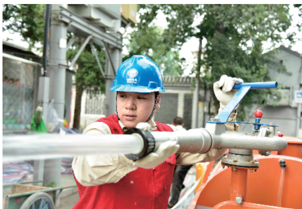
利用洒水车洒水降尘
