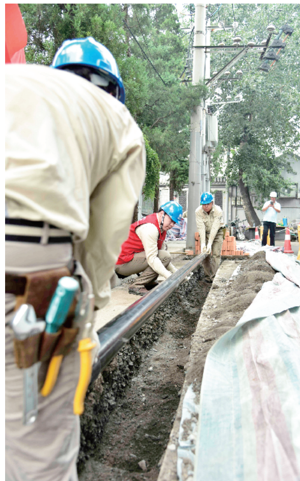
铺设电缆管道
