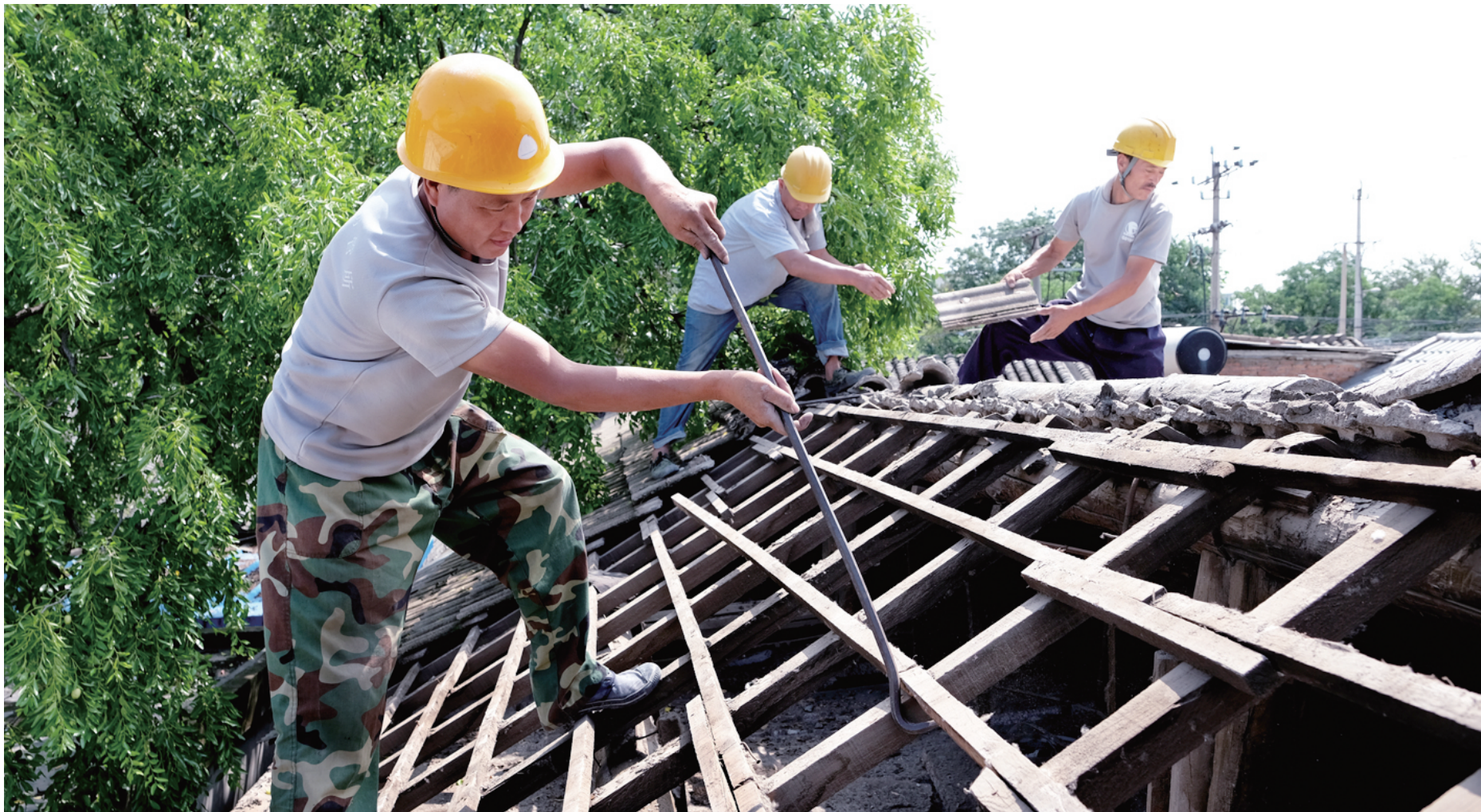
为保障居民安全，房顶局部换瓦要当天完成。
