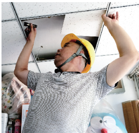
▲到居民家中查找漏点。
