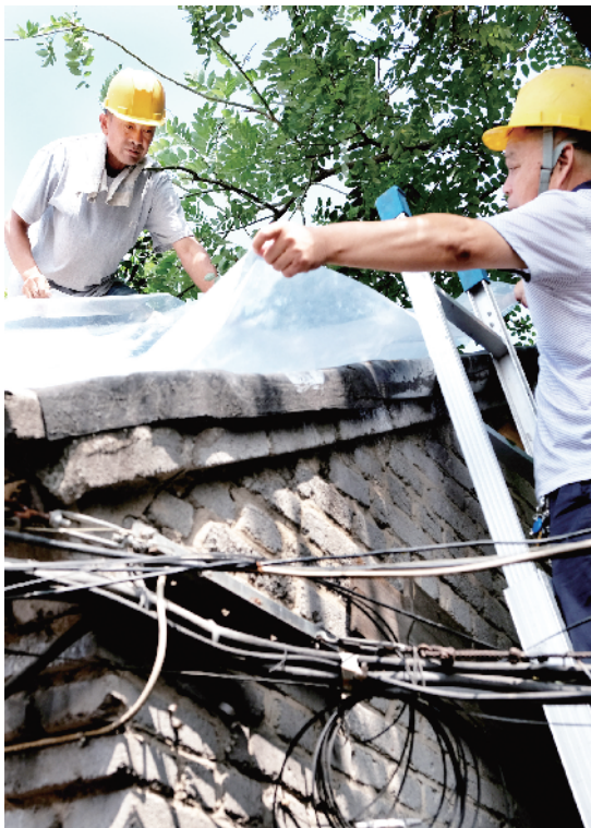
►工人对一些刚维修好的房屋铺盖雨布。
