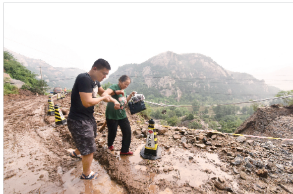
在抢修中, 工人为急需出山的村民提供方便。
