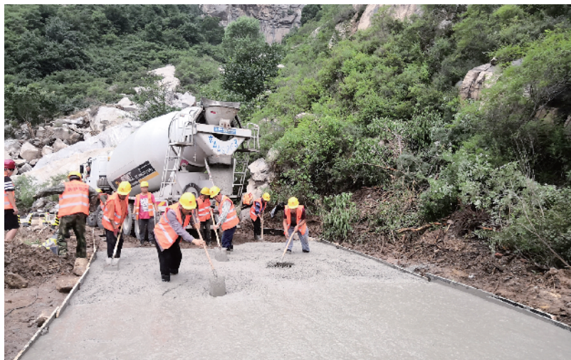
临时打通的路面, 需要快速的浇灌水泥, 保障车辆通行。
