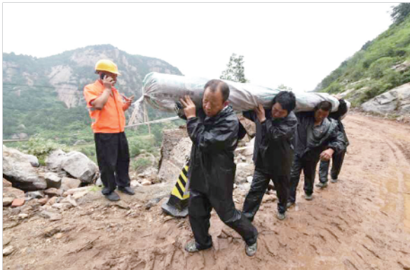
刚铺好的路面不能走车, 工人就用肩扛搬运物资。
