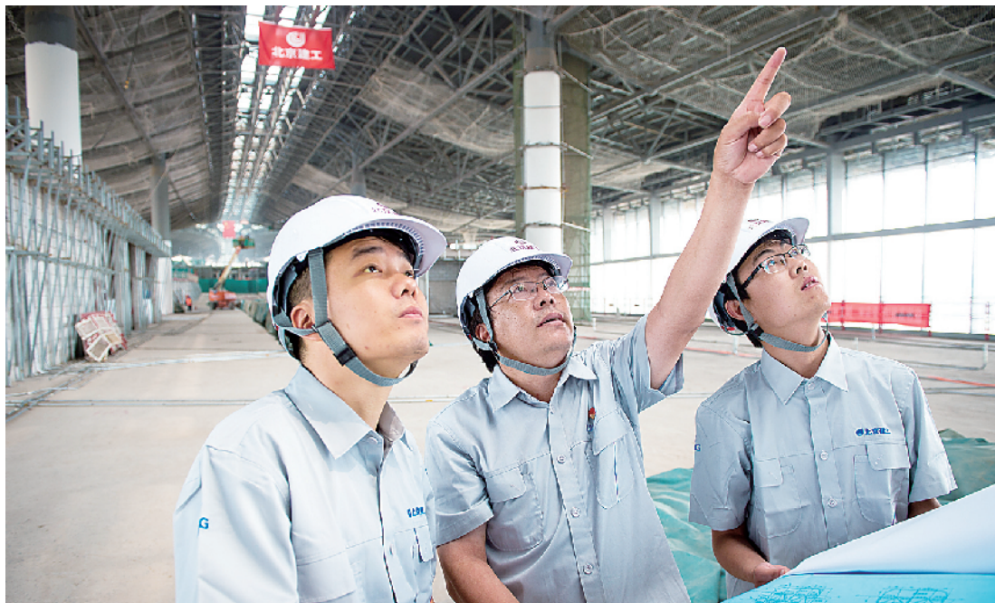
胡鸿志(中)在项目施工现场
