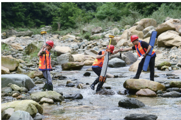
测绘队员跋山涉水为施工提供精准数据。
