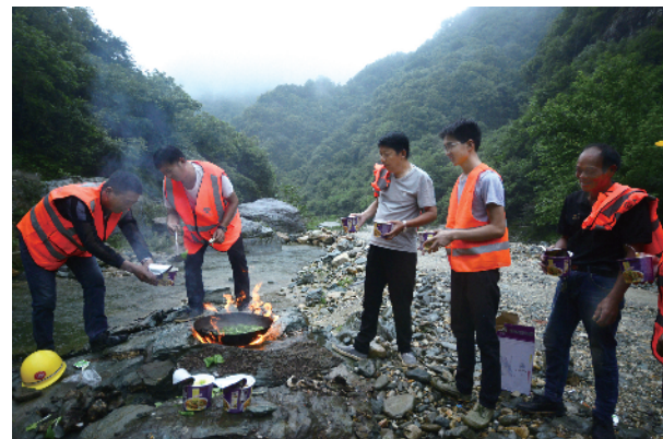
施工人员每天风餐露宿是家常便饭。
