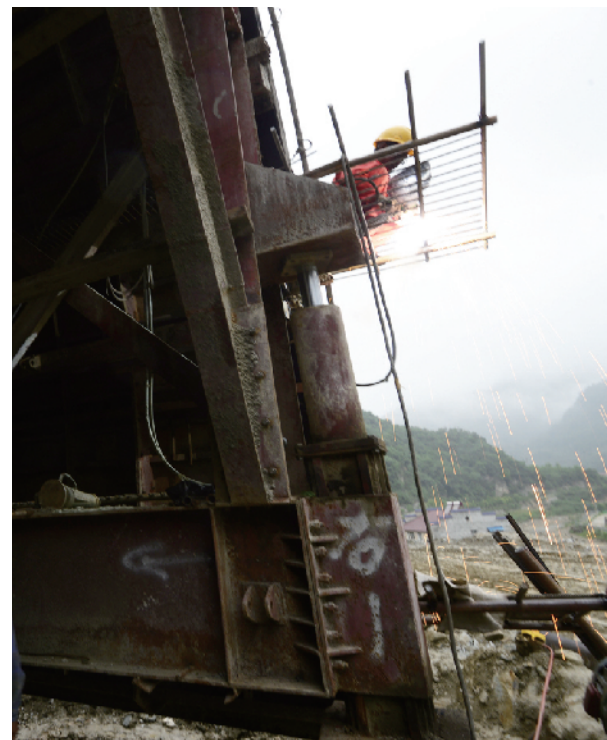
隧道施工地质复杂、湿度大，是最难啃的一段“硬骨头”。
