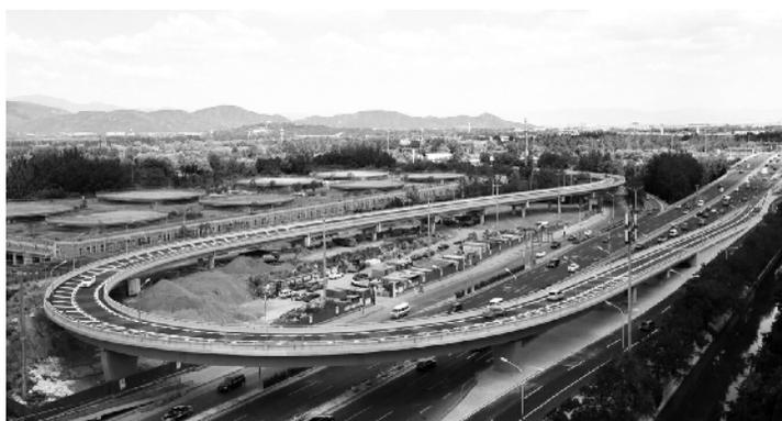
确定了匝道改造方案。项目于2017年3月17日开工建设。该工程在四环主路内环方向万泉河桥出口处,新建一条西向北远引匝道,
