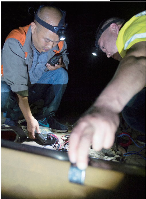
▲工人逐一核对信号机、道岔、轨道电路联锁关系是否正确。
