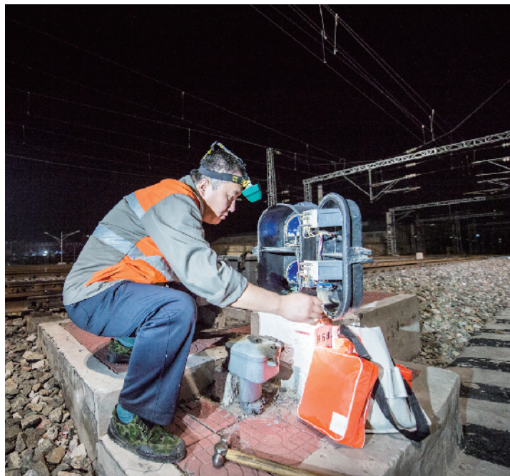
工人在对出站信号机进行测试。
