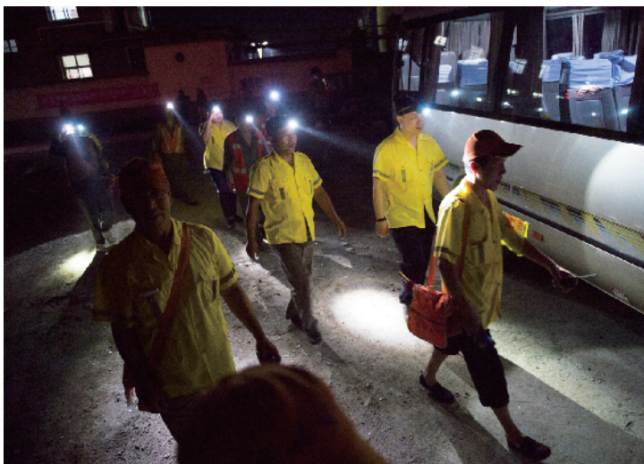
21时30分，施工人员整装上车，前往河北施工现场。
