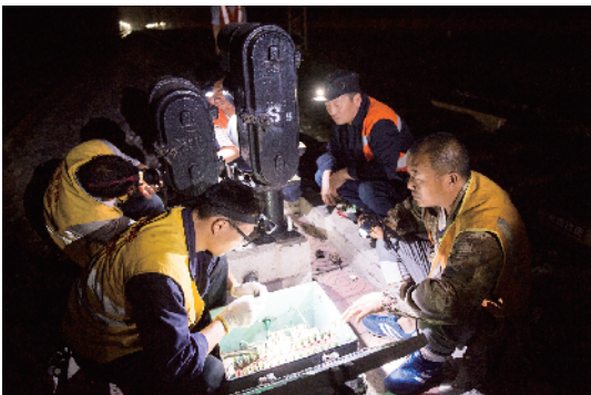
技术人员开始对出站信号机进路表示器进行测试。
