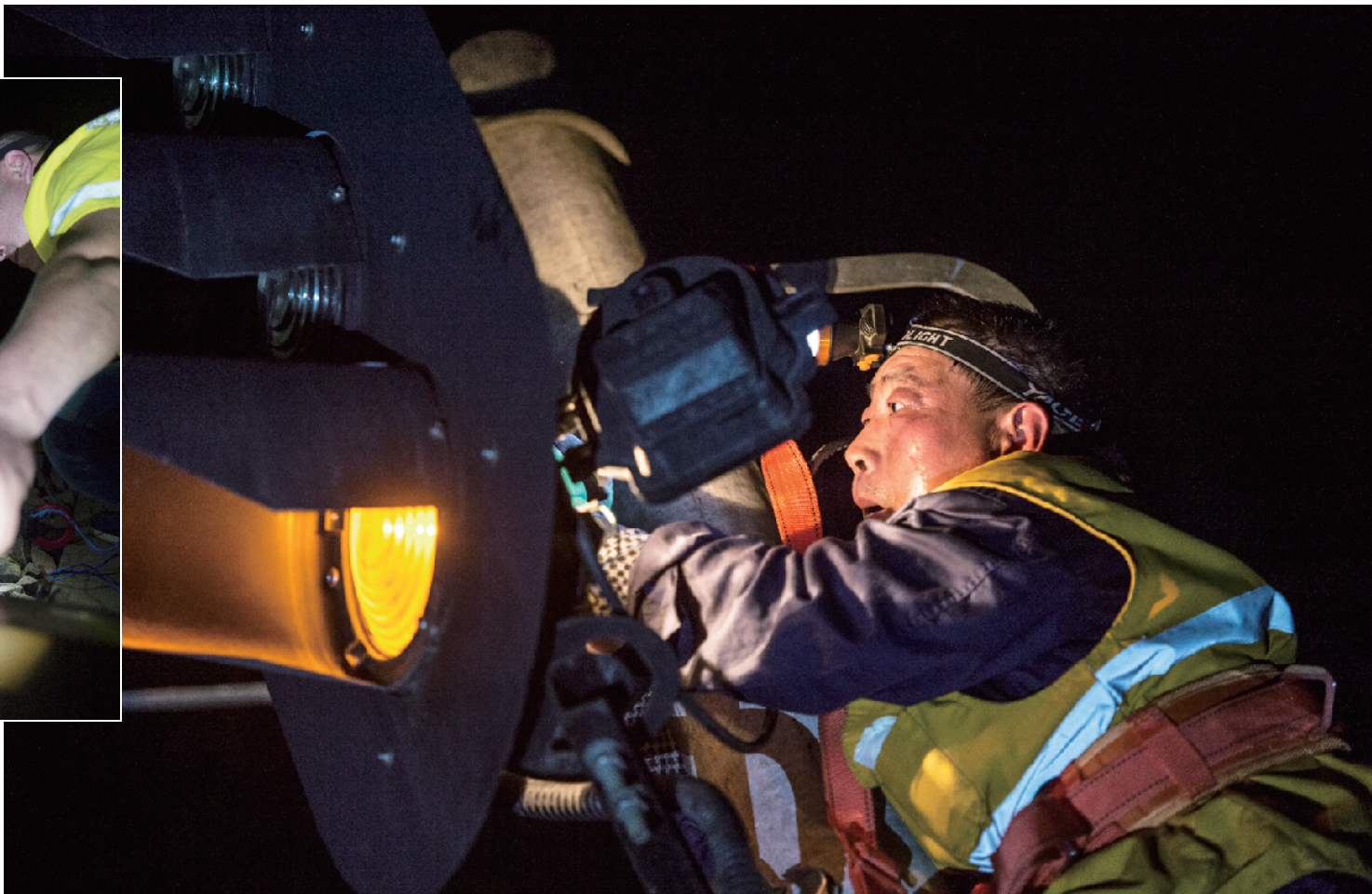
▲工人逐一核对信号机、道岔、轨道电路联锁关系是否正确。
