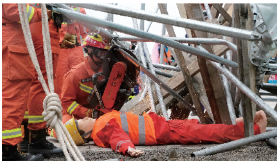
施工现场支架倒塌后，救援队利用拆解工具快速抢救被困人员。
