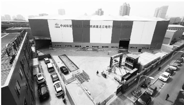
内,车站北侧主要为居住用地和教育科研用地,东侧和西侧分布有居民区和商业区,周边环境对现场施工的绿色环保要求较高。经过各方反复研究论证,决定在香河园站东端明挖段采用固定式防尘隔离棚全封闭施工。
