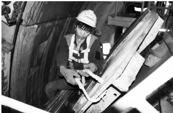
工人正在为隧道安装管片
