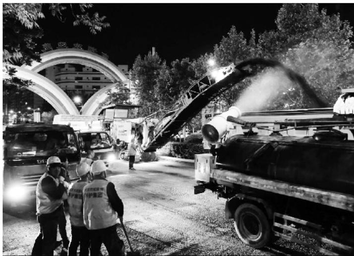
工程管理科科长王超介绍,后厂村路现状道路通行条件极差,且周边路网车流汇入后交通量大,交通拥堵十分严重,路面出现疲劳变形情况,存在大面积严重碎裂甚至下沉,严重影响道路的通行条件和服务水平。
